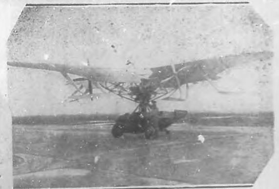
Este aeroplano sin cola, que parece condenado a caer tan pronto como remonte el vuelo, es—en opinión de algunos expertos—el avión del futuro. Se basa en el mismo principio que el "autogiro" de La Cueva.
